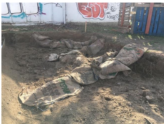
Ilustrační foto ochrany kořenů v případě nutných výkopů
